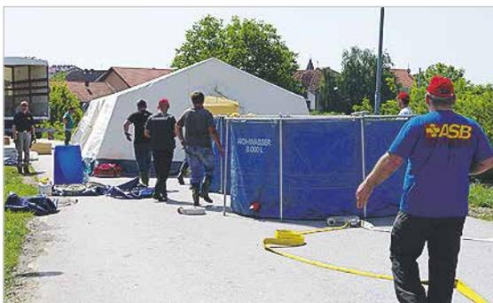
Die Absetzbecken werden mit dem Rohwasser befüllt.
